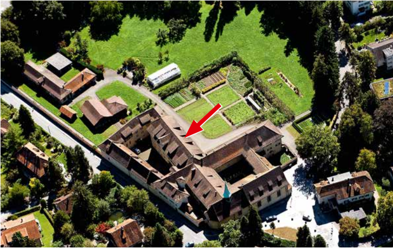
Das Kapuzinerkloster Wesemlin in Luzern. Der rote Pfeil zeigt den Trakt, in den die Wohnstudios eingebaut werden.
