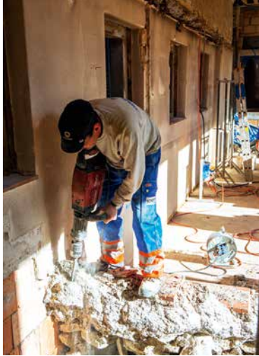
Damit Neues entstehen kann, muss Altes weichen: ein Handwerker an der Arbeit für die Wohnstudios.
