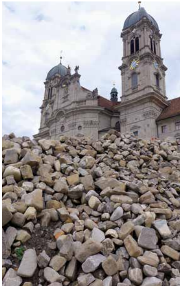
Baustelle Kirche: Steinhäufen vor dem Kloster Einsiedeln.
