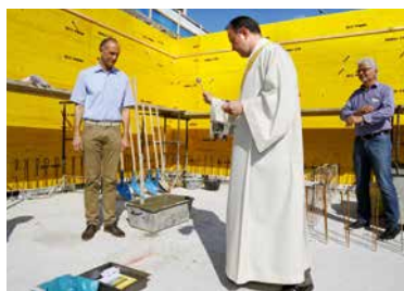
Gemeindeleiter Daniel Unternährer segnet die Metallbox, die als Grundstein einbetoniert wurde.
