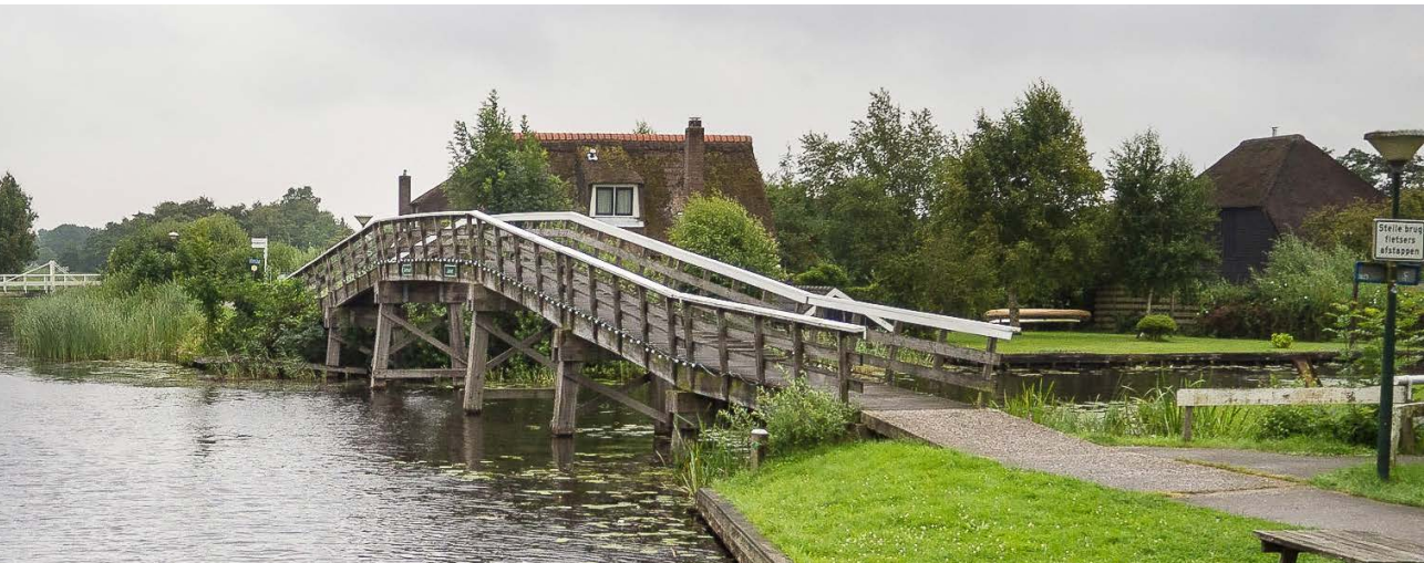
Bild: Gregor Gander; Brücke in Holland
