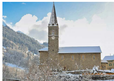
Die Kirche in Troistorrents wurde 1722 erbaut. Nun müssen Mauern und Gewölbe saniert werden. Bild: zVg
